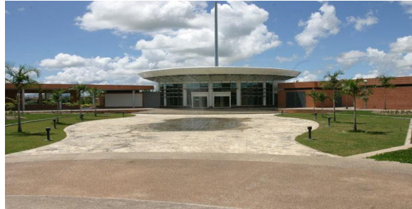
Figura N° 07: Vista del Centro de Control de Operaciones del Metro Valencia (CCO)
