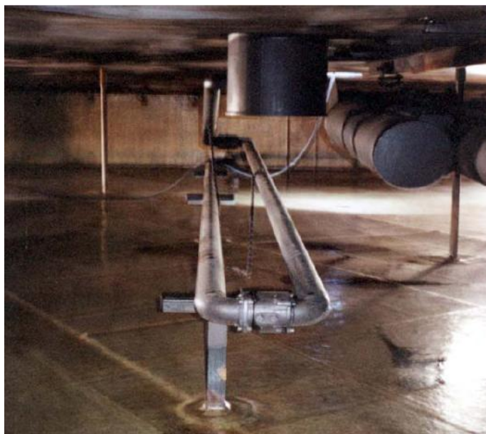
Figura N° 5. Sistema de drenaje de tubería rígida. Recién instalado
