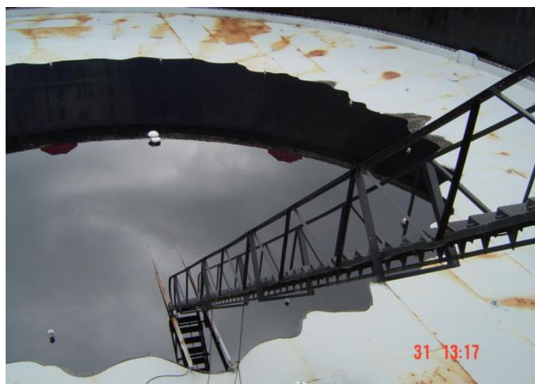
Figura N° 2. Petróleo Acumulado Sobre el Techo Flotante
