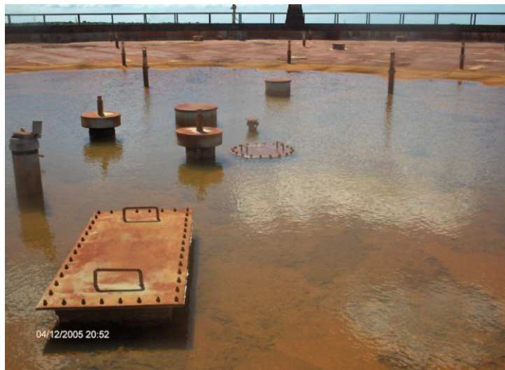
Figura N° 1. Agua Acumulada Sobre el Techo Flotante
