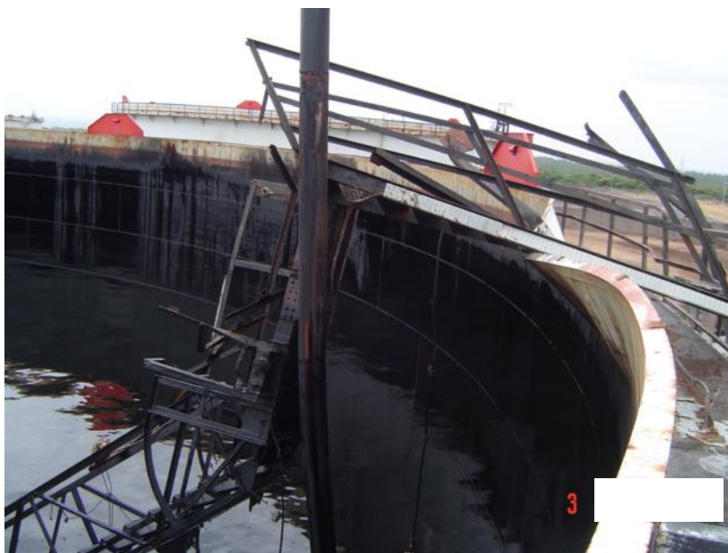
Figura Nº 4. Tanque Colapsado por exceso de peso en el Techo Flotante
