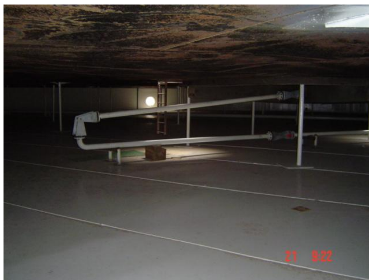
Figura N° 3. Sistema de Drenaje de Agua de Lluvia de Tubería Articulada
