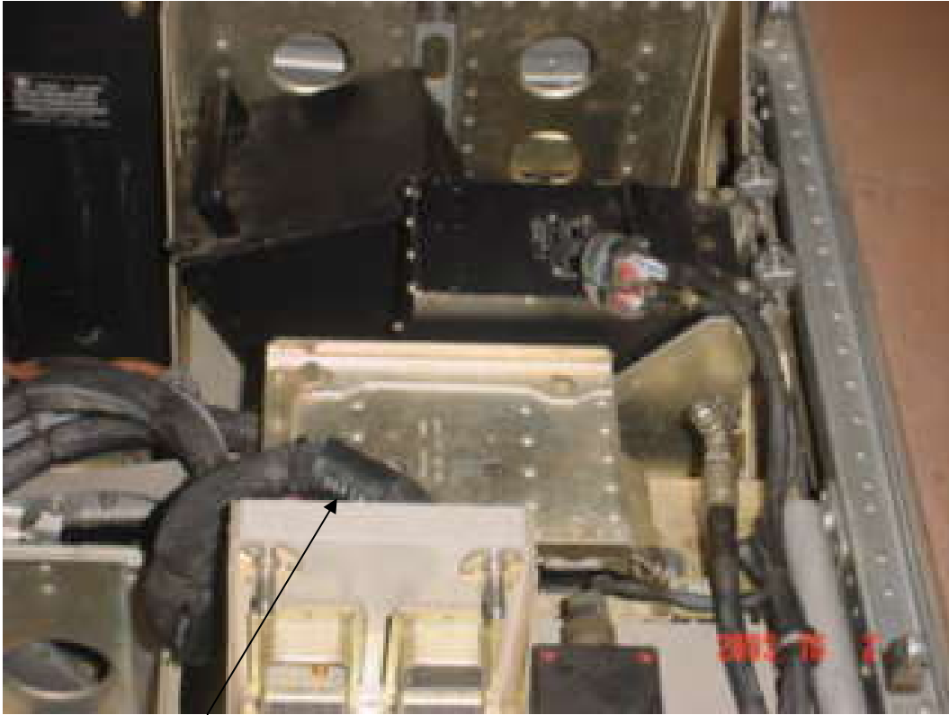
Compartimiento de Equipos Electrónicos
